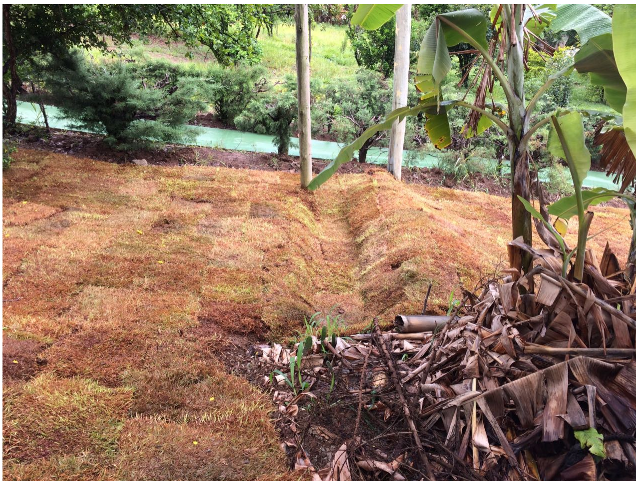
Figura 26 – Início das obras na Nascente da Escola Oásis da Esperança
